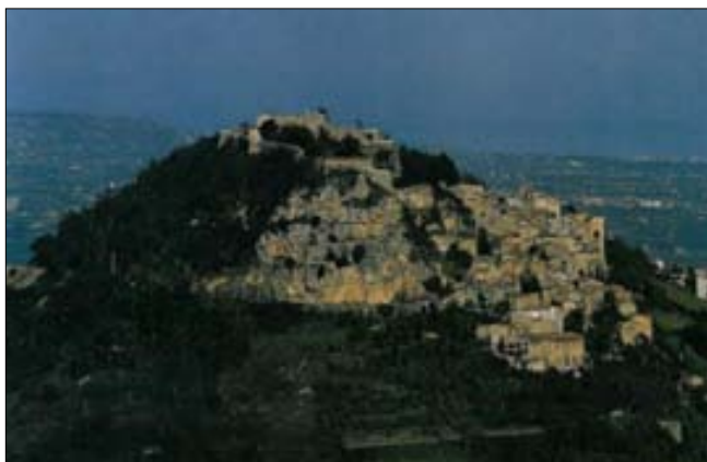
Figura 28: Vista della parete Est della placca di travertino di Civitella del Tronto, su questo versante si raggiungono spessori di circa 60m, mentre sul lato occidentale la roccia si assottiglia fino a poco più di 5 m
