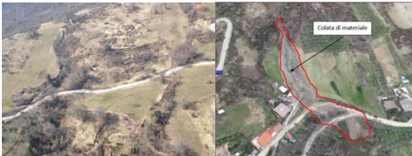
Foto 3: movimento franoso complesso alle porte della Frazione di Ripe. L'area è stata perimetrata ed è stato richiesto l'inserimento nel PAI sulle more dell'art. 24 delle N.A.
