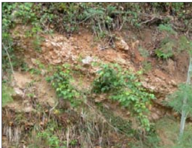
Figura 37: detrito di falda affiorante a E dell'abitato di Civitella del Tronto.
